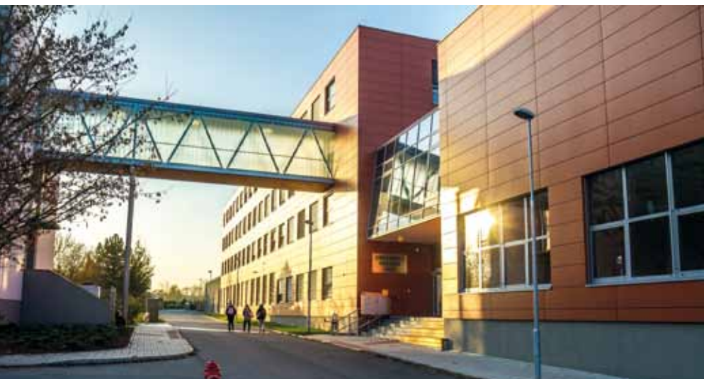
Dřevařský pavilon FLD, investice za 280 mil. Kč, je propojen s původní budovou FLD skleněným tubusem.
