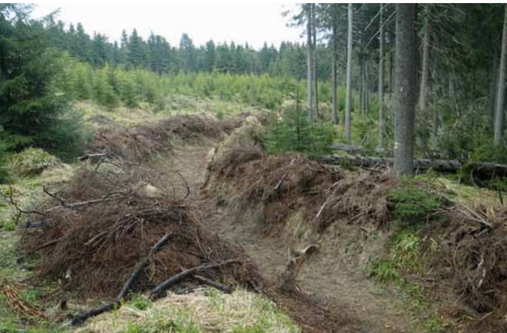
Ukázka nově vyhloubeného a vyčištěného odvodňovacího příkopu.
