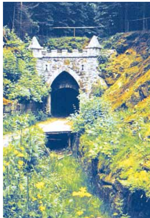
Naši předkové dokázali vytvořit díla nejen technicky dokonalá, ale i estetická a monumentální, jak dosvědčuje portál tunelu na Schwarzenberském kanálu na Jeleních Vrších.
