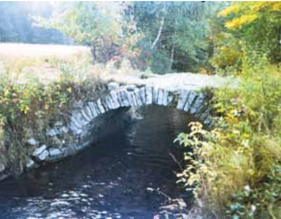
Současný vzhled mostku na Vchynicko-Tetovském kanálu.
