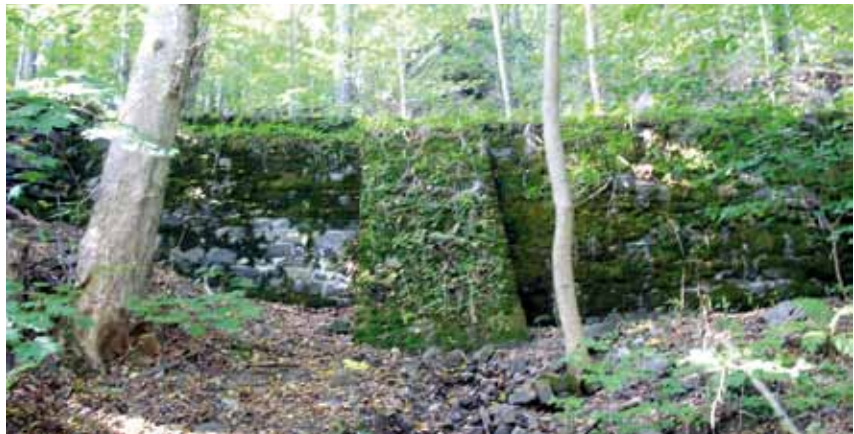
V těch částech trasy, kde nebylo možné vést Weissshuhnův kanál rostlým terénem, je jeden břeh kanálu tvořen opěrnou zdí.
