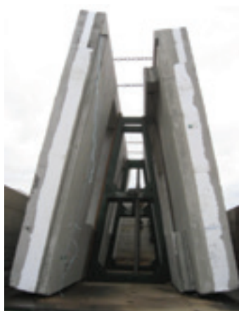
Obrázek 46: Odnímatelný rám ve tvaru A
