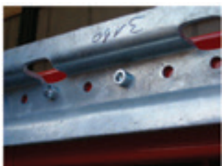
Obrázek 11: Kotvící tyč
